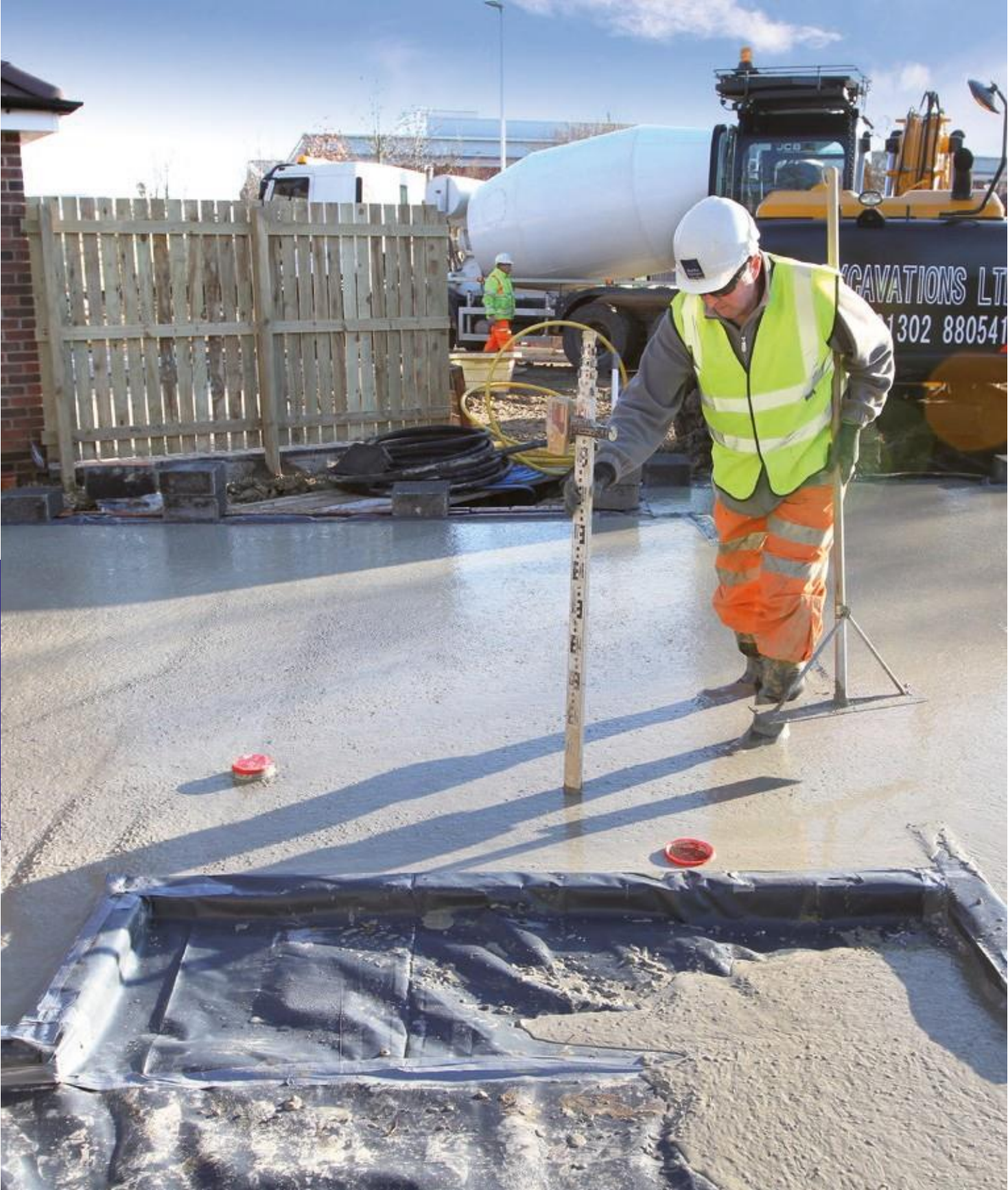
Nahoře: Měření trhlin po smrštění plastu digitálním mikroskopem Dole: Tlaková vrstva vytvořená pomocí Výztuž do betonu Durus EasyFinish
